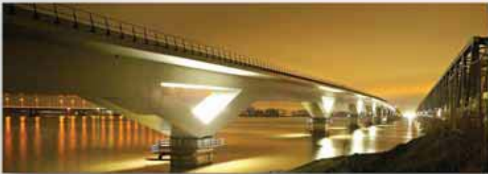
HSL Bridge, Moerdijk/Netherlands
